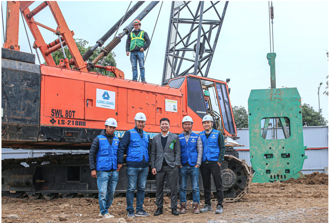
Long Giang Foundation khởi động máy trong lễ khởi công dự án Tòa nhà Oriental Square
